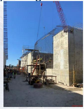
281-FILTER MODULE- Backfilling 72" BWW
