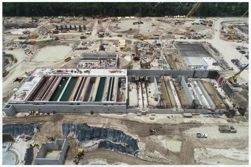
281-FILTER MODULE-Forming/Reinforcing Walls
