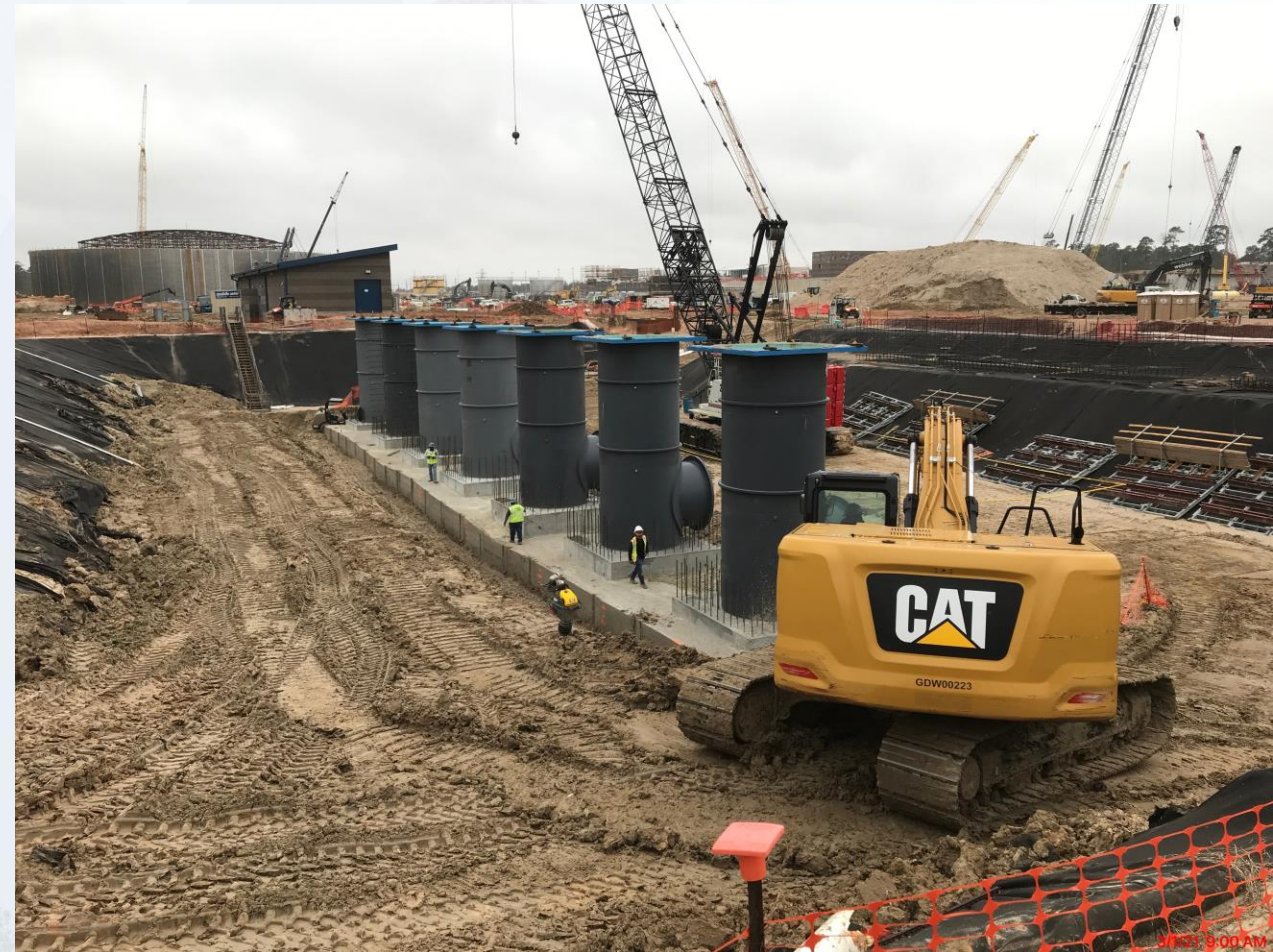
Completed CLSM pour in lieu of pump can backfill
