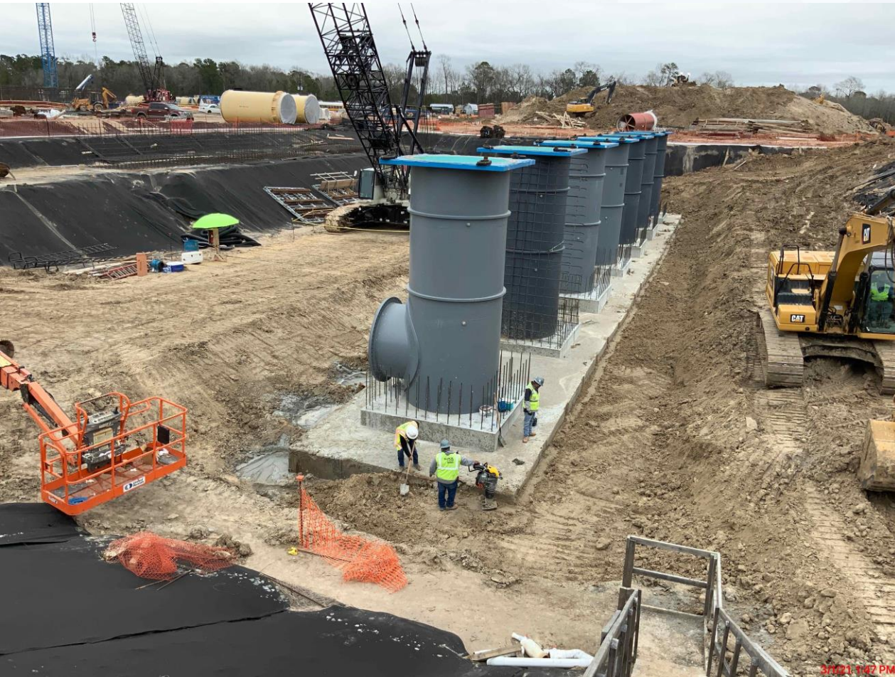
Completed CLSM pour in lieu of pump can backfill
