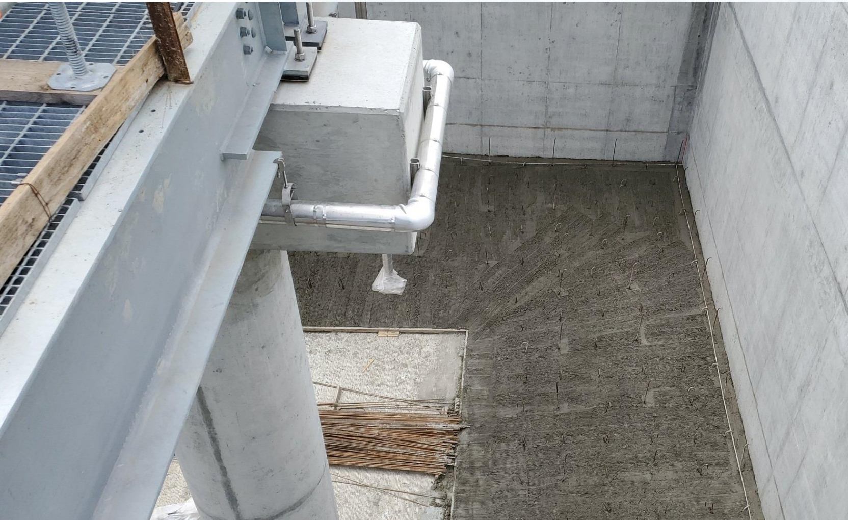
Commenced slope fillet pour at Fac 510
