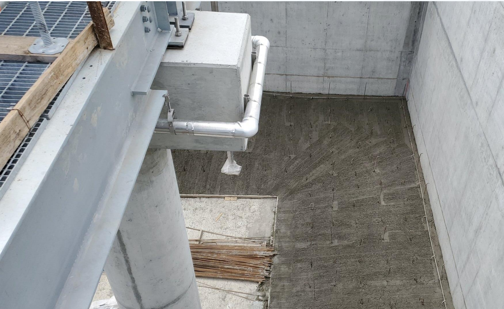
Commenced slope fillet pour at Fac 510
