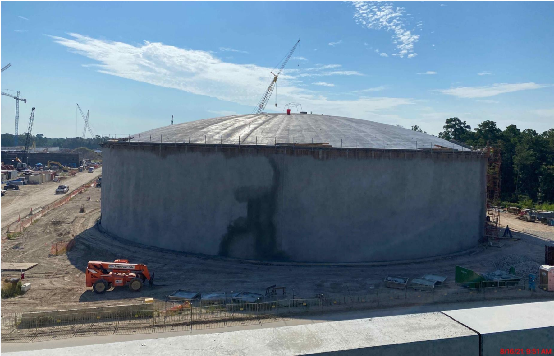
361 – Completed dome pour
