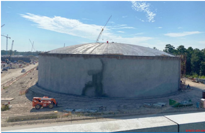
Completed Dome Pour GST 361
